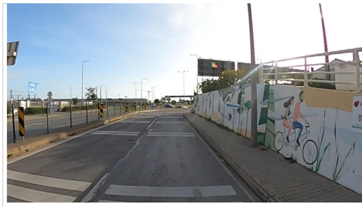
Figura 4 – Vista ao km 2+500 para o troço em estudo
